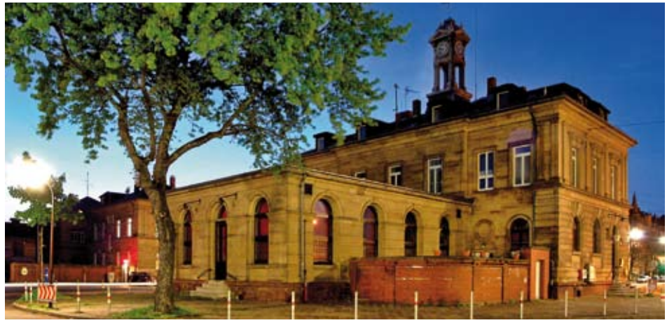
Eingangssituation zum Schlachthof
