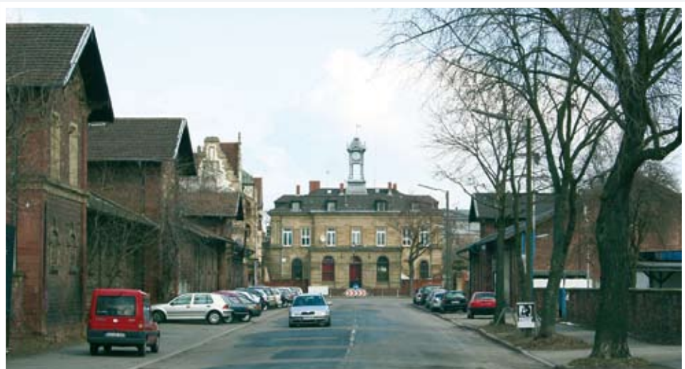
Gebäudeensemble des Schlachthofs
