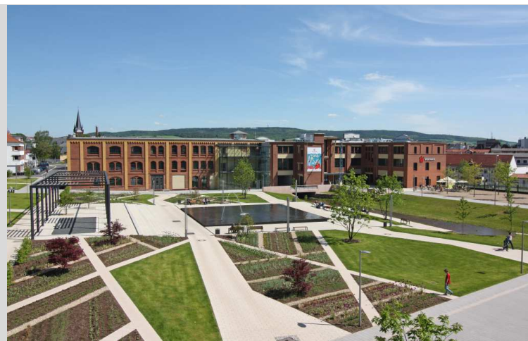
Plaza und Stockwerksfabrik Foto: Stück, Braunschweig/HMUKLV
