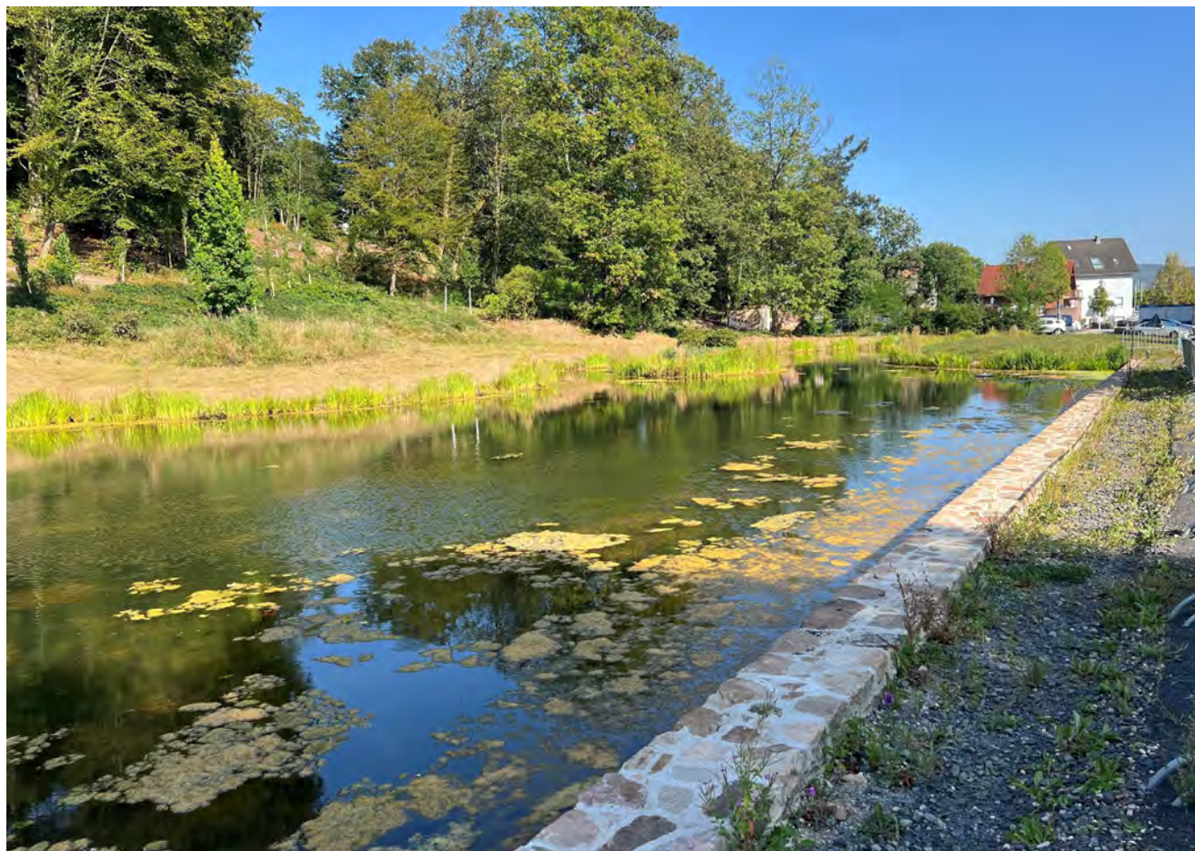
BILD: Schlossweiher und Damm nach der Sanierung
