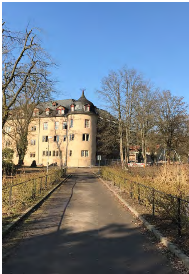
BILD LINKS: Schloss und Damm vor der Sanierung, Foto Ihle Wirth
