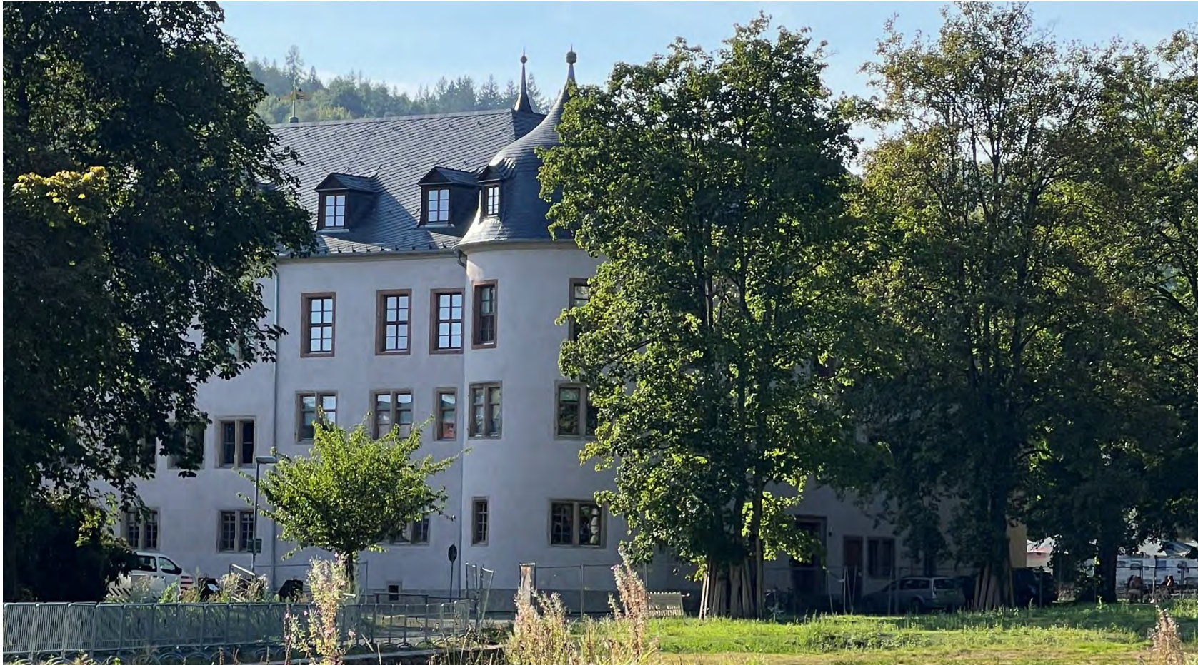
BILD: Schloss und Damm nach der Sanierung, 2024
