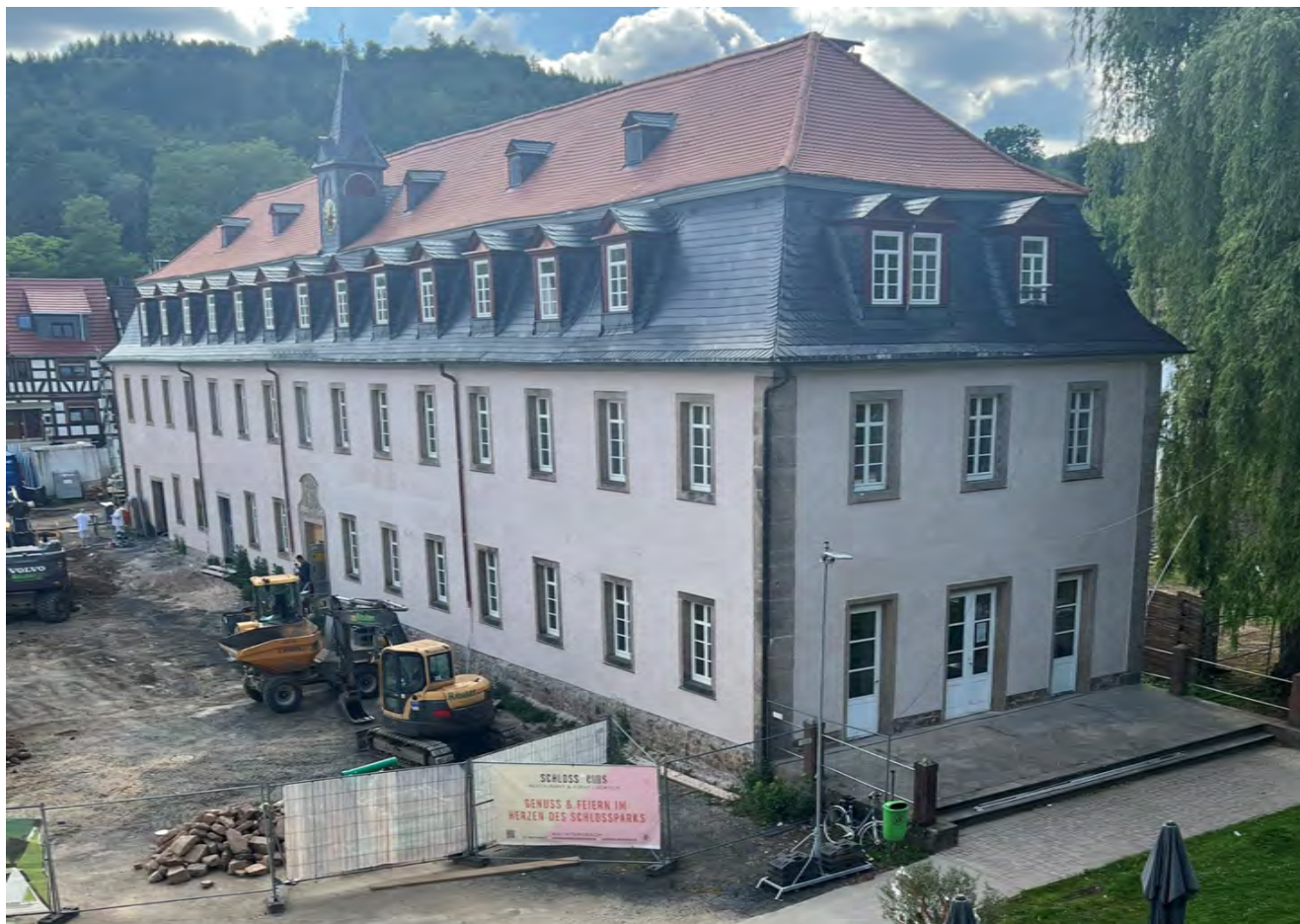
BILD: Rentkammer nach der Sanierung, 2026
