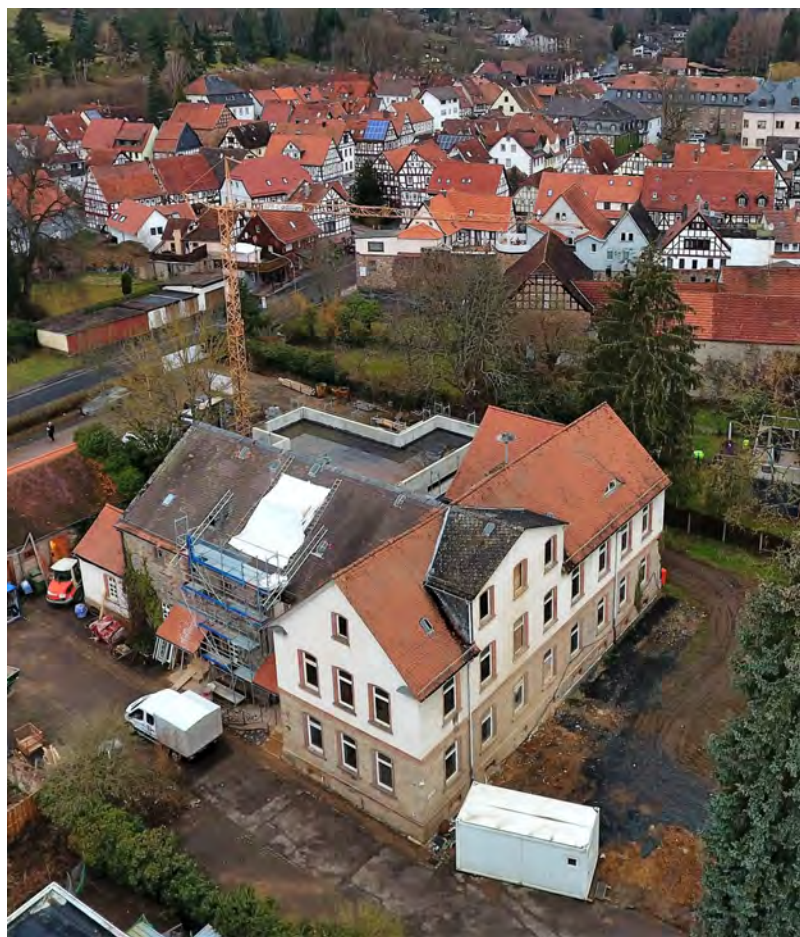
BILD LINKS: Während der Umbauphase 2021
