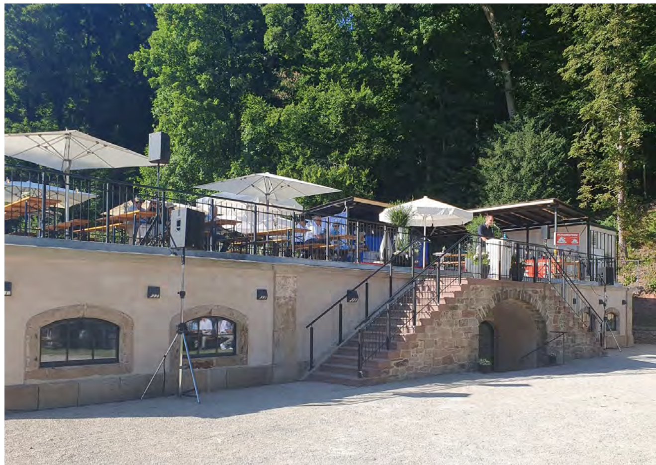
BILD RECHTS: Ansicht des beidseitig begehbaren Treppenaufgangs zur Schlossparkterrasse
