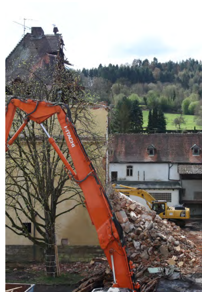
BILD: Abbruch Sudhaus 2018
