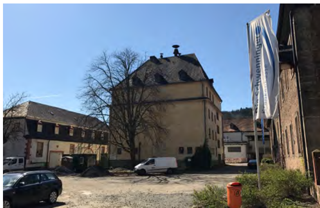
BILD: Sudhaus vor dem Abriss, 2018
