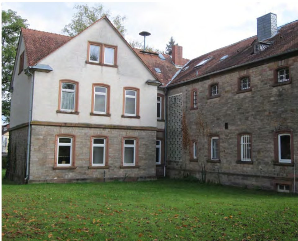
BILD LINKS: Rückseite vor Anbau 2020
