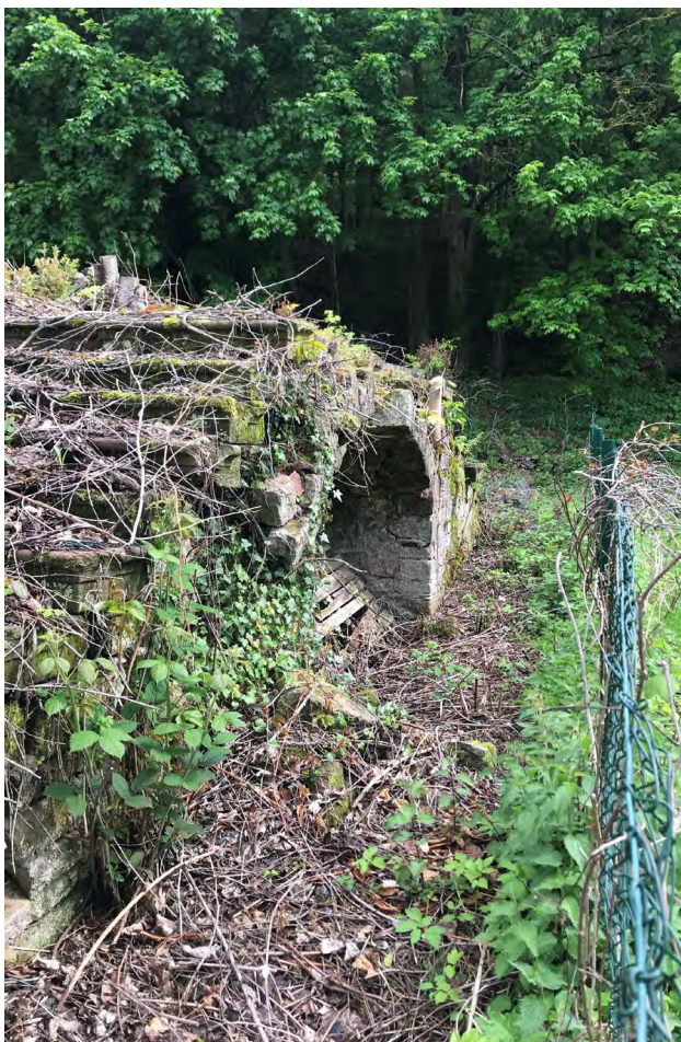
BILD: Treppenaufgang Schlossparkterrasse, 2021
