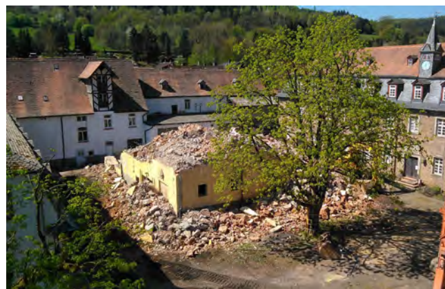
BILD: Abbruch ehemalige Fassbinderei, nördliches Brauerei-Areal, 2020
