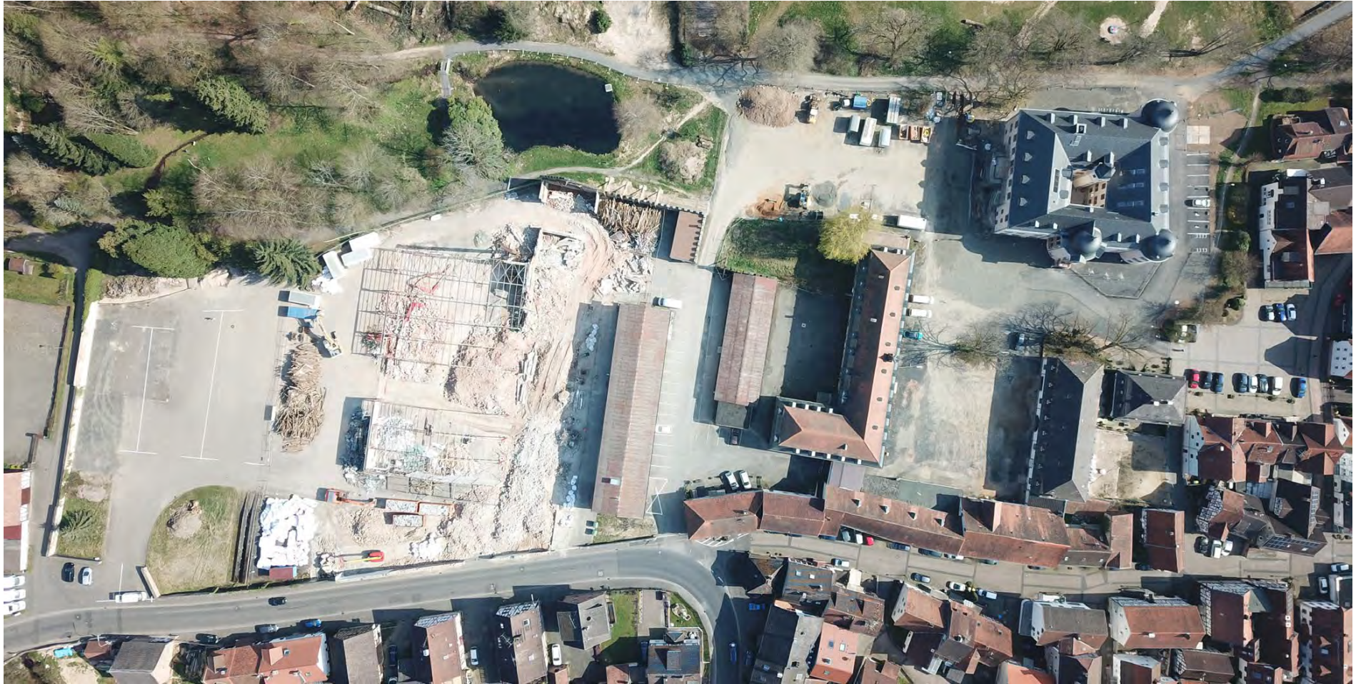
BILD: Abbruch, nördliches Brauerei-Areal, 2020
