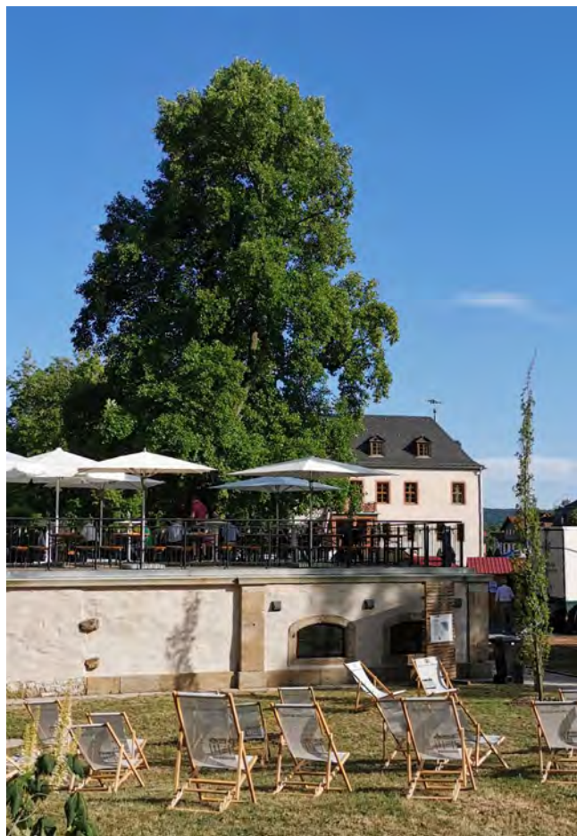
BILD LINKS: Schlossparkterrasse nach der Sanierung Blick Schloss- und Brauerei-Areal
