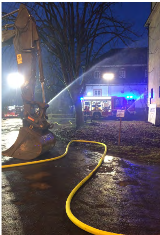
BILD: Öffentliche Abrissparty mit Übungseinsatz Feuerwehr und THW
