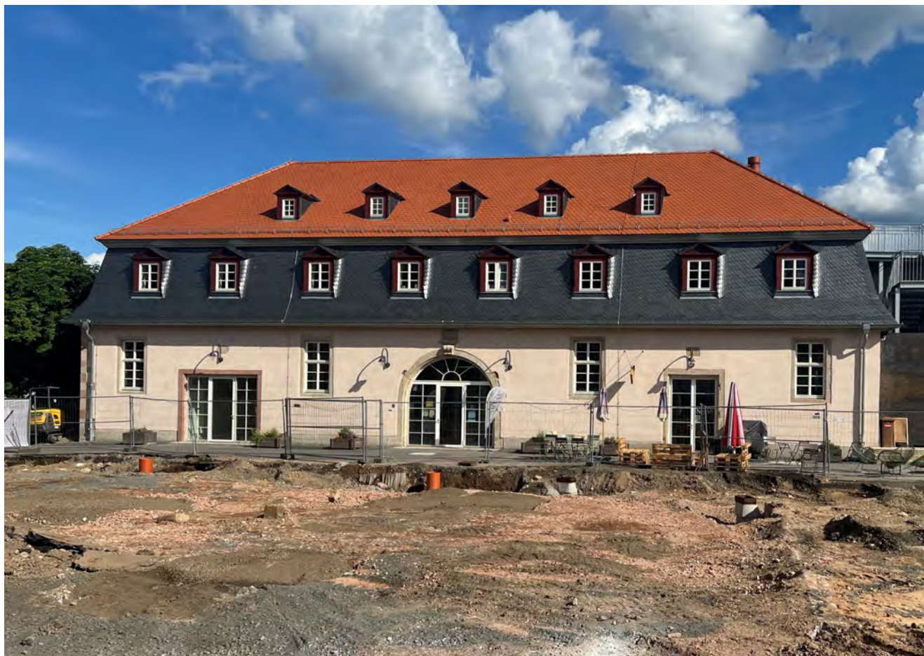
BILD: Marstall nach der Sanierung; 2026
