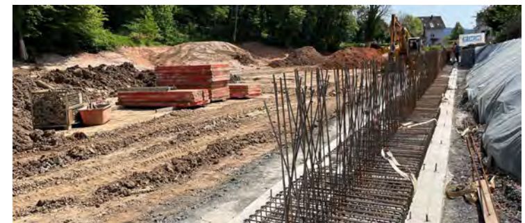
Foto: Herstellung der Stützmauer für den Damm, 2023
